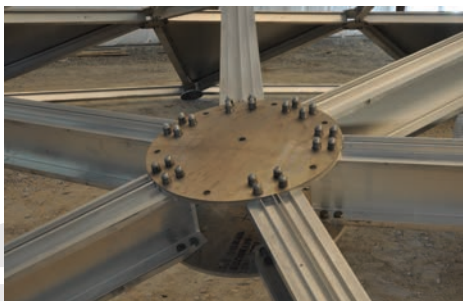
En el detalle de nodo, se utiliza un diseño de extrusión exclusivo
